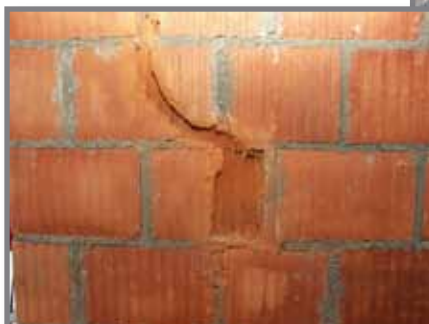
Ostavlja čiste kanale
